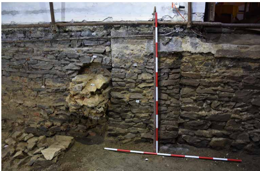
Obr. 4: Krnov, barokní refektář kláštera; nároží východního (s. j. 977) a severního (s. j. 959) ramene gotické křížové chodby, zeď vlevo (s. j. 967), druhotně vložená do východního ramene gotického ambitu, představuje základ východní části jižní stěny barokního refektáře. © foto František Kolář, 2018
