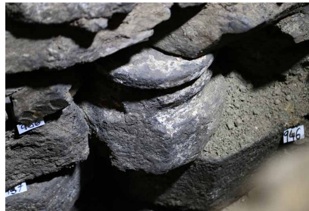
Obr. 18: Krnov, klášter minoritů; svorník klenby, asi 1340–1354, druhotně využitý v barokním základovém zdivu. © foto Dalibor Prix, 2020
