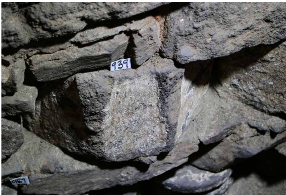
Obr. 17: Krnov, klášter minoritů; dílec osmibokého pilíře klenby s výběhy klínových, na bocích vyžlabených žeber, asi 1340–1354, sekundárně vezděný v barokním základovém zdivu. © foto Dalibor Prix, 2020
