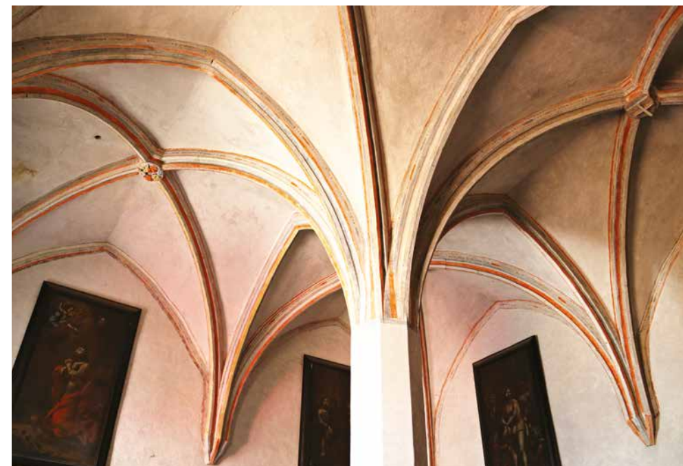
Obr. 20: Litomyšl, bývalý klášter augustiniánů-eremitů, sakristie, po 1360 až 1364, centrální oktogonální pilíř s výběhy klenebních žebor na hranách dříku. © foto Dalibor Prix, 2018
