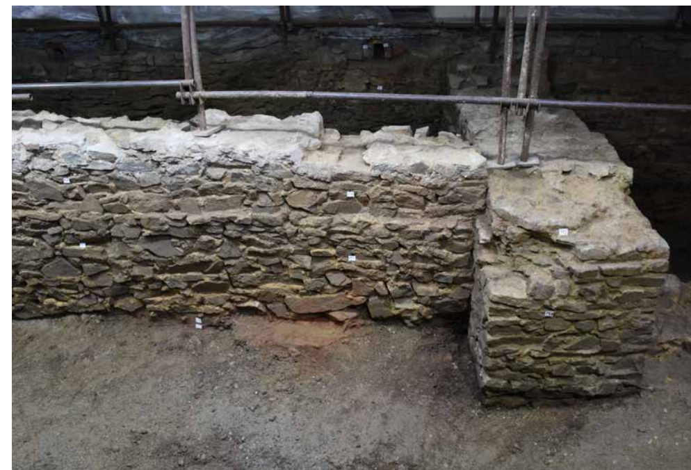
Obr. 3: Krnov, barokní refektář v severním křídle kláštera; západní obvodová zeď (s. j. 918) severní části východního ramene gotické křížové chodby s navazující severní obvodovou zdí (s. j. 919) severního ramene ambitu; stav po ukončení archeologického výzkumu. Pod základovou spárou zdiva s. j. 919 je patrná jižní část starší pece, související se sídlištními aktivitami předcházejícími výstavbě zděných budov kláštera. © foto František Kolář, 2018
