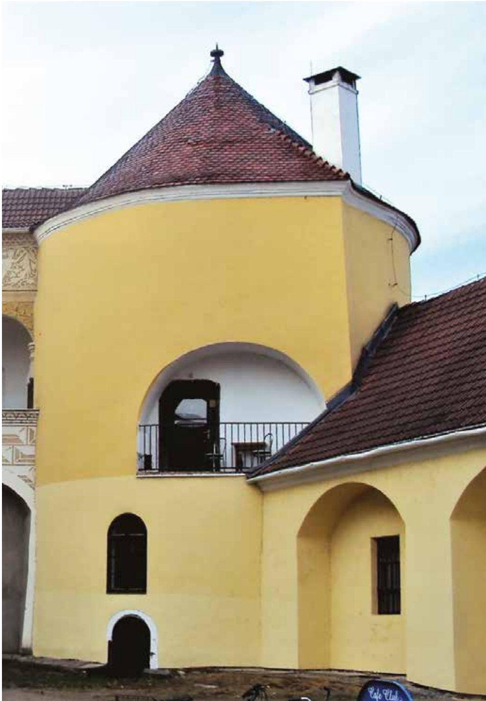
Obr. 91: Archaizující věž s břitem z doby kolem 1530 na hradě markraběte a knížete Jiřího Zbožného Hohenzollerna v Krnově, pohled od nádvoří.
